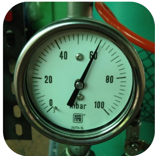
รูปที่ 8 แสดงการติดตั้ง Low Gas Pressure Regulator และ เกจวัดแรงดันก่อนเข้าสู่อุปกรณ์
